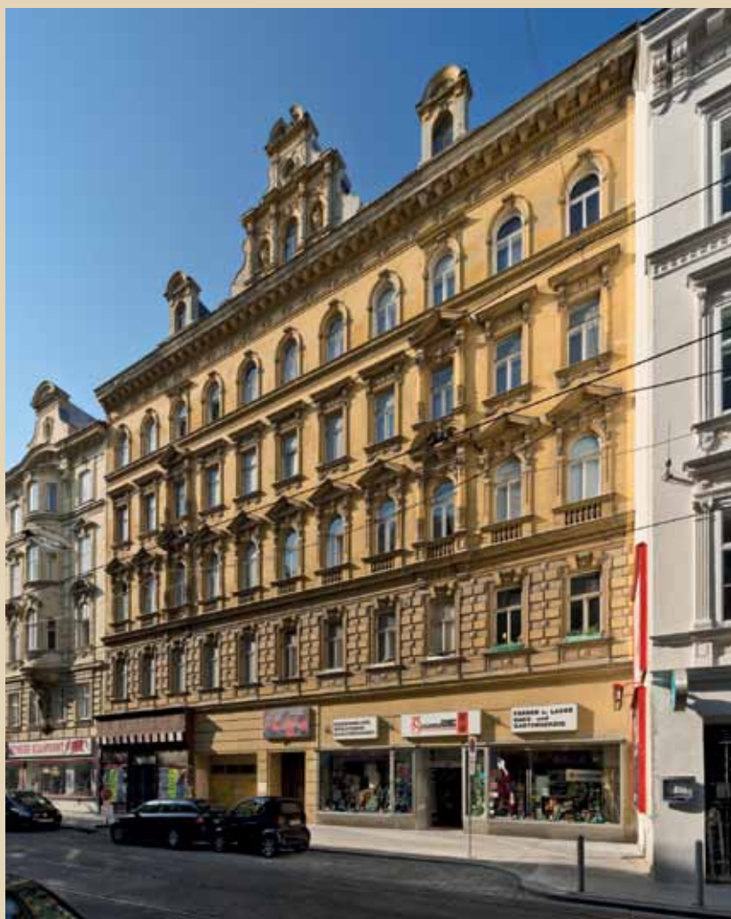
Alle Objektbilder vor Revitalisierung
